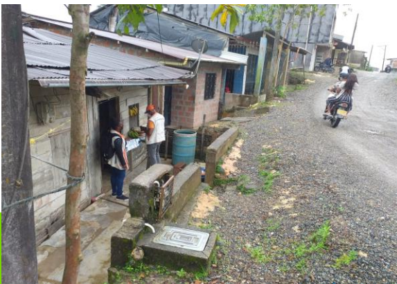
Actualización y levantamiento de información para el proceso de vinculación al servicio de acueducto y aseo.
