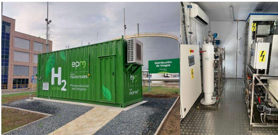
Con el Hidrógeno producido será posible realizar un *Blending* (Mezcla) con biogás e inyectar en motogeneradores de energía, dualización de volquetas para trabajar mezclas Diesel - Hidrógeno y un *Blending* en la red actual de gas natural para su uso en las actuales aplicaciones de cocción.
