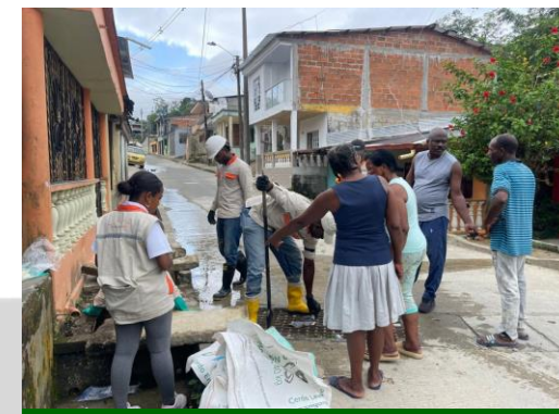
Apoyo a jornada de limpieza al canal de desagüe de lavado de filtros
