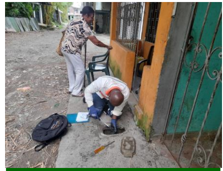
Apoyo en la reinstalación del servicio de acueducto en el barrio Alameda Reyes
